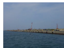
護岸工事の様子
