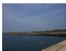
整備中の基地港湾予定地
