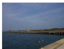
整備中の基地港湾予定地
