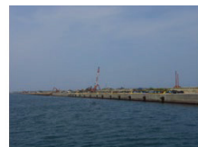
護岸工事の様子
