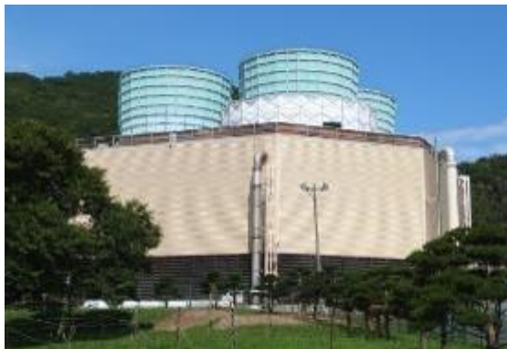
北海道電力(株) 森地熱発電所
