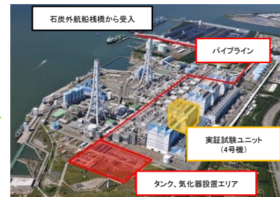
港湾・臨海部立地産業が利用 (例: 碧南火力発電所におけるアンモニア混焼実証)
