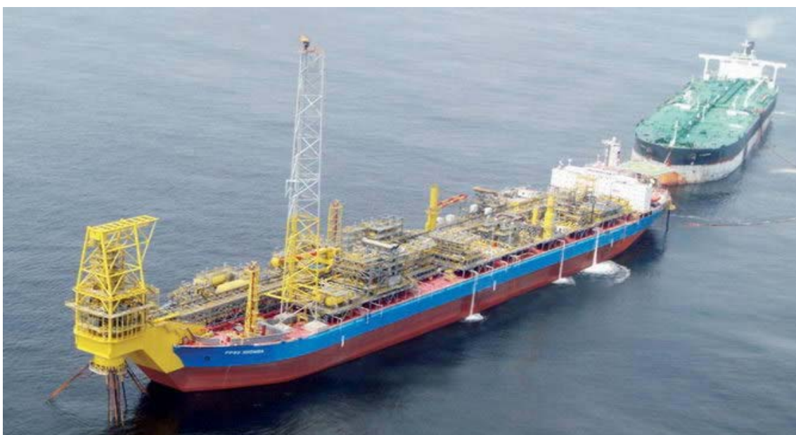
<図表-2> FPSO “Xikomba” (後方はシャトルタンカー)
